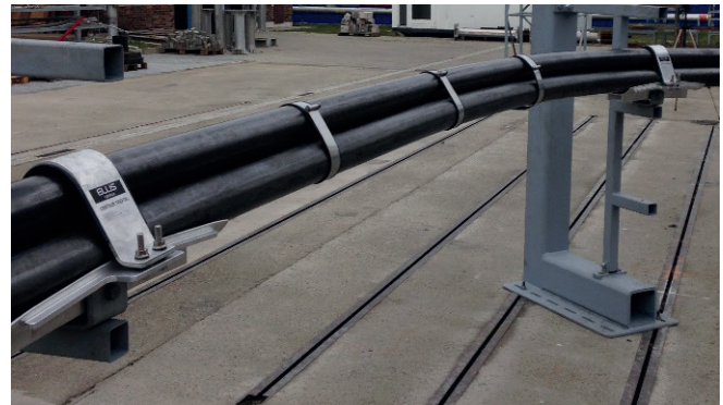
FOTO DO EQUIPAMENTO DE TESTE DE CURTO-CIRCUITO DO TRIFÓLIO CENTAUR. TESTE CONDUZIDO NOS LABORATÓRIOS ZKU EM PRAGA, REP. CHECA.
